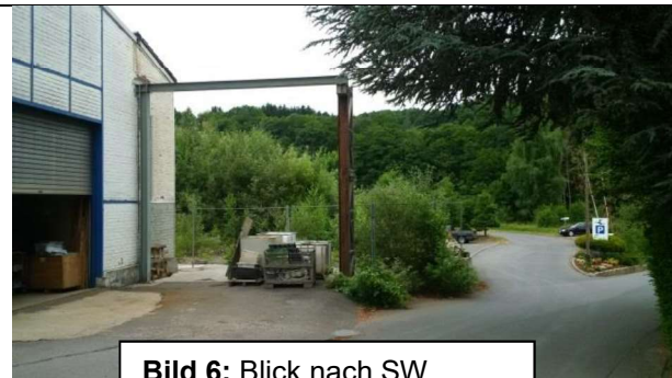
Bild 6: Blick nach SW
