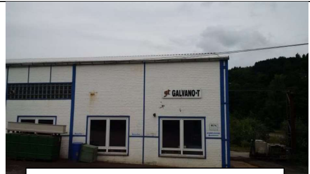
Bild 2: Blick nach SW auf Werkshalle
