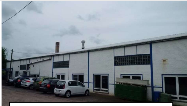
Bild 1: Blick nach S auf Werkshalle
